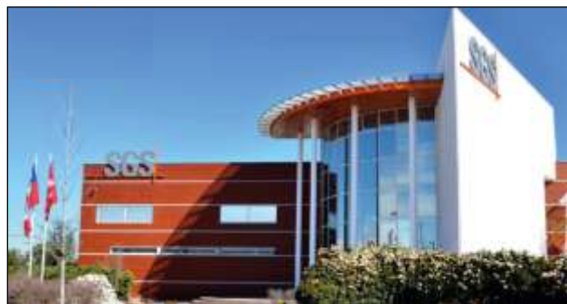
Figura 1. Instalaciones de SGS. Ubicadas en Pudahuel.
