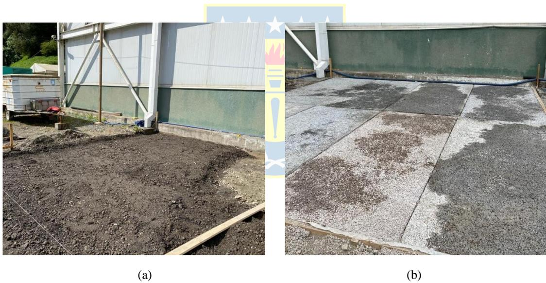
Figura 3.8. Estacionamiento realizado con losas cortas. (a) Colocación de base y (b) losas realizadas
