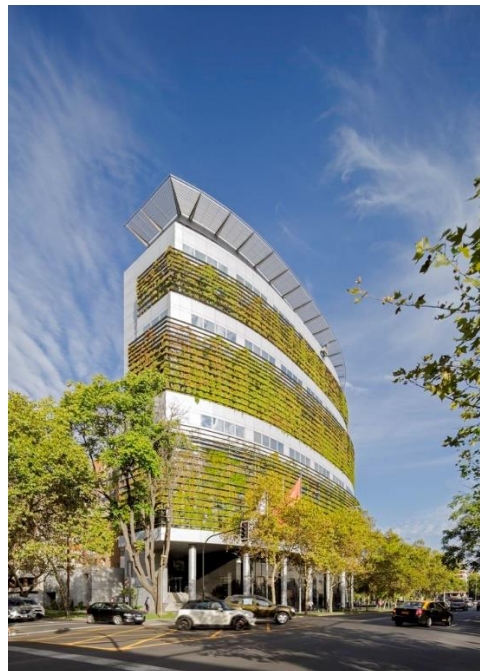
Figura 2.3 Edificio Consorcio Santiago
