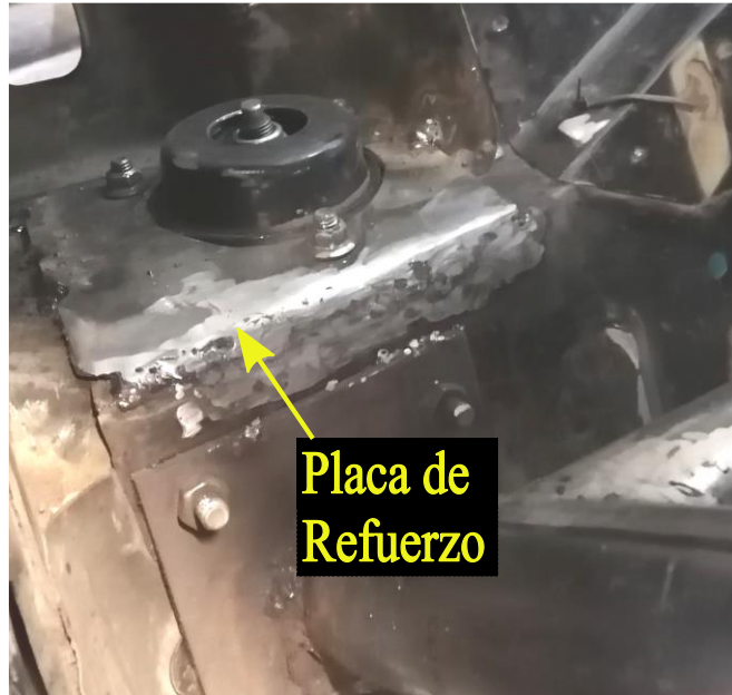
Figura 4.15. Refuerzo cazoleta trasera.
