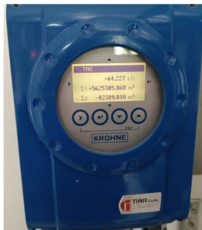
Figura 19: Caudalímetro IFC 050, Krohne, Alemania. Fuente: Krohne
