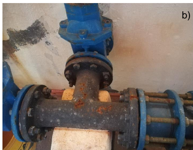
Figura 1. a) caseta de cloración b) presencia de corrosión en tuberías.
