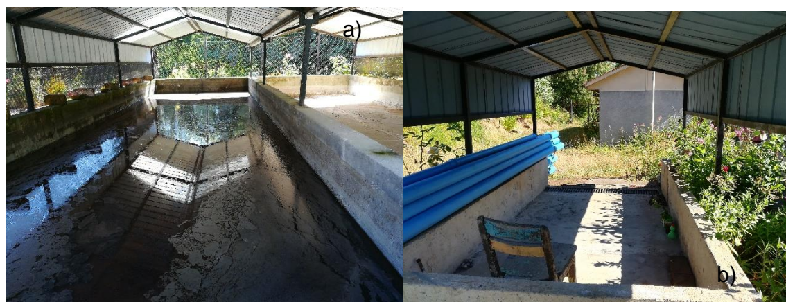
Figura 2. a) se cancha de secado de lodos activados, b) zona de acopio de lodos activados.
