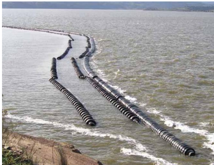
Figura 2.4 Ejemplo rompeolas flotante tipo cadena de llantas
