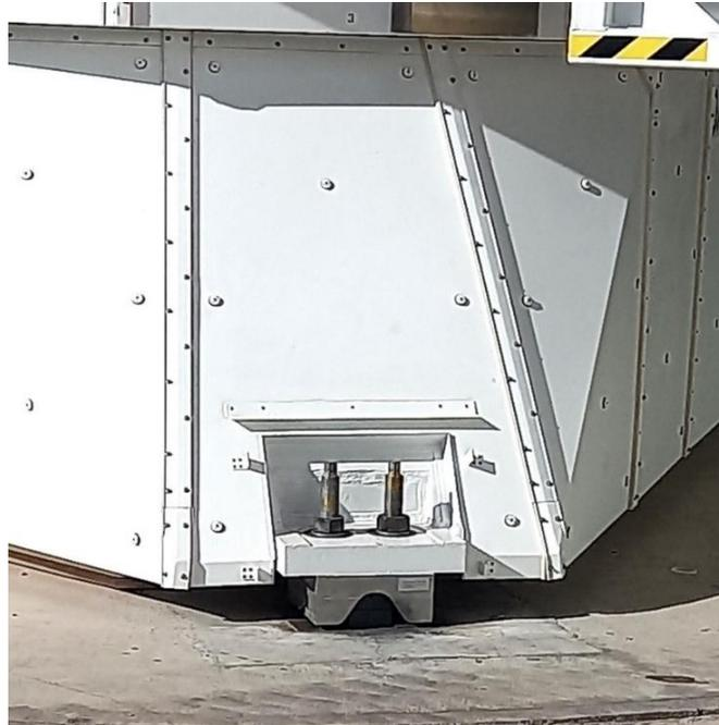
**Figura 9: Soportes de la antena Vertex.**
