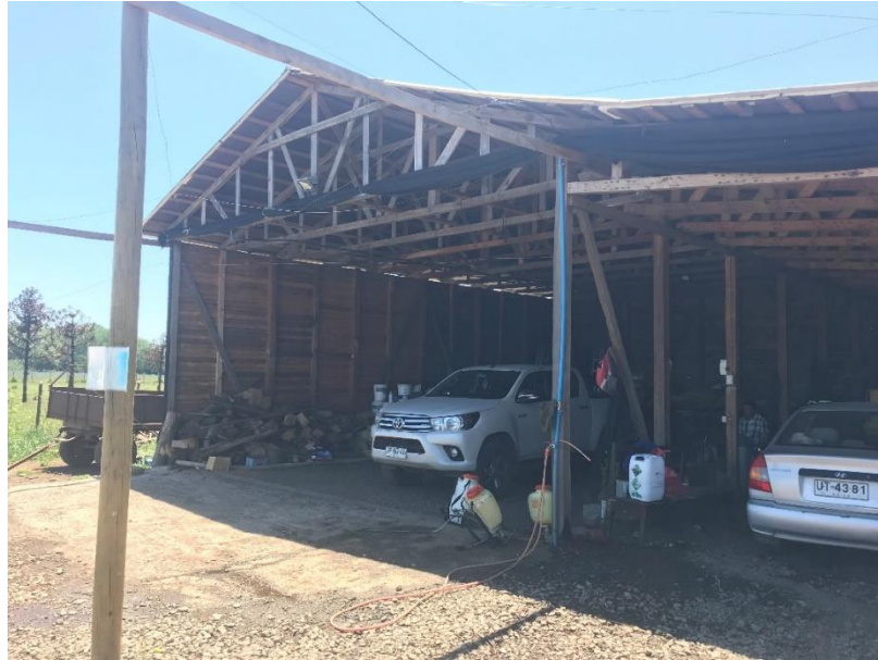
Figura 16. Imagen de la zona de carga en el interior del predio Santa Elena y de la ubicación que tendrá la cámara de pre-frío.
