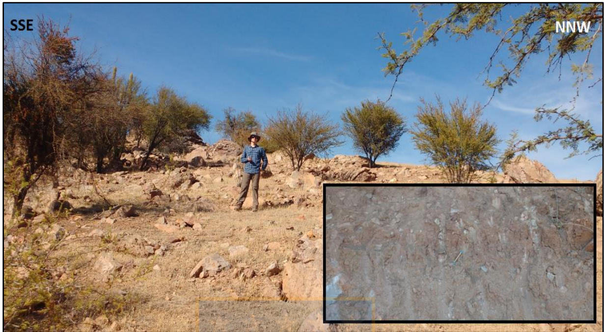
Figura 5.11. Depósitos coluviales y/o residuales. En la parte inferior derecha se observan los escombros en un corte de camino.
