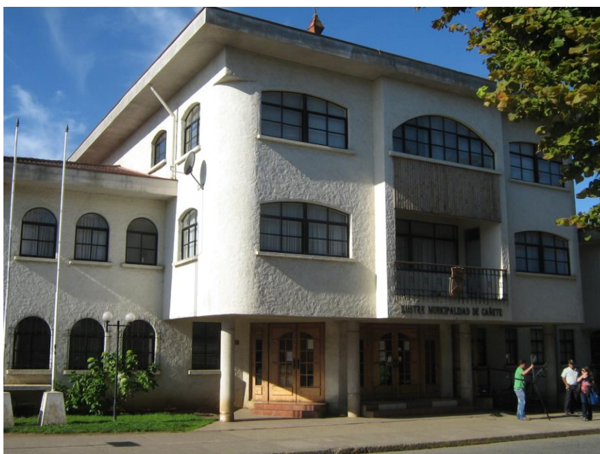
FIGURA Nº 12: ILUSTRE MUNICIPALIDAD DE CAÑETE
