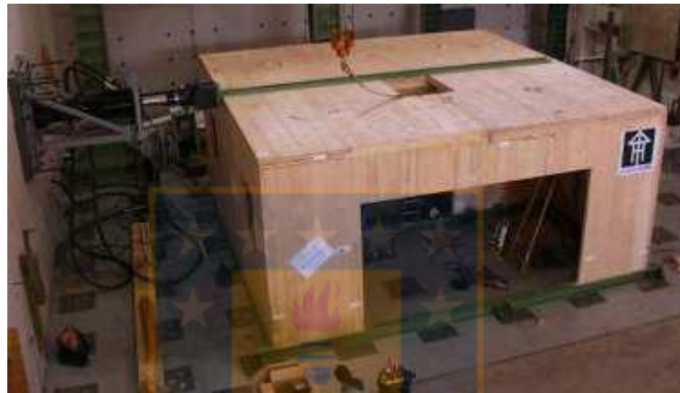
a) Ensayo estructura de un piso
