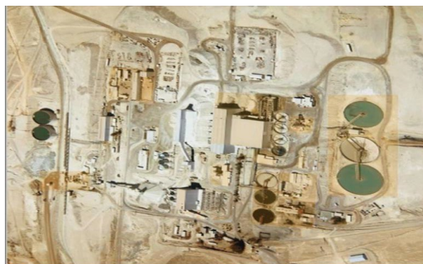
Vista aérea de la Planta Concentradora de la División Salvador-CODELCO.
