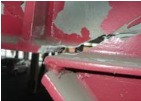
Figura 2.2: Rotura enlace (Oyarzún, 2012) Figura 2.3: Deformación inelástica enlace (Oyarzún, 2012)
