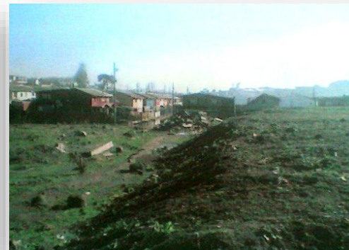
FIGURA 68. Vía sin pavimento, escombros - abandono, año 2008.
