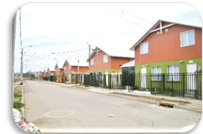
Vista Prolongación calle Castellón.
