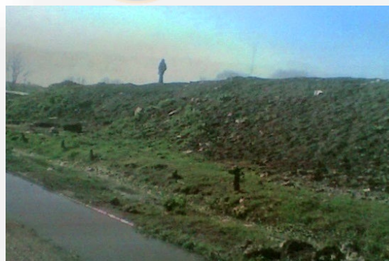
FIGURA 69. Aposamiento agua por mal drenaje – Quema pastizales, calle Manuel Gutiérrez, año 2008.
