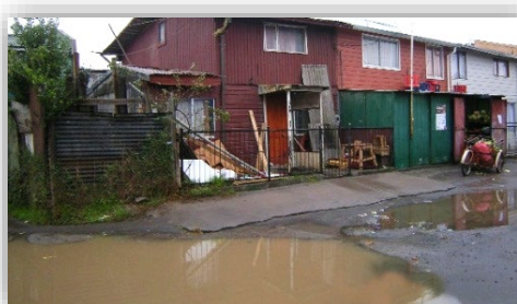
FIGURA 88. Aposamiento agua mal drenaje vías, calle Manuel Gutiérrez, año 2014.
