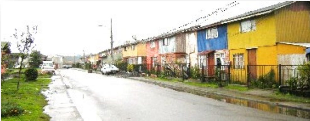
Viviendas Calle Irene Frei.
