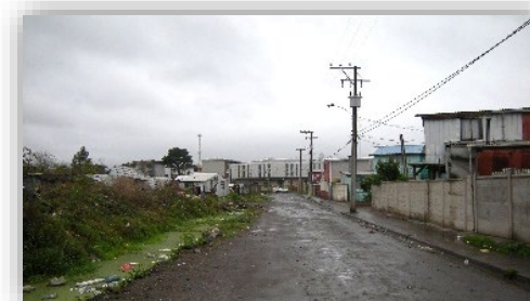
FIGURA 89. Vista M. Gutiérrez sin pavimento en estado de abandono, año 2014.
