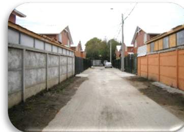
Vista pasaje 1 desde calle Castellón.
