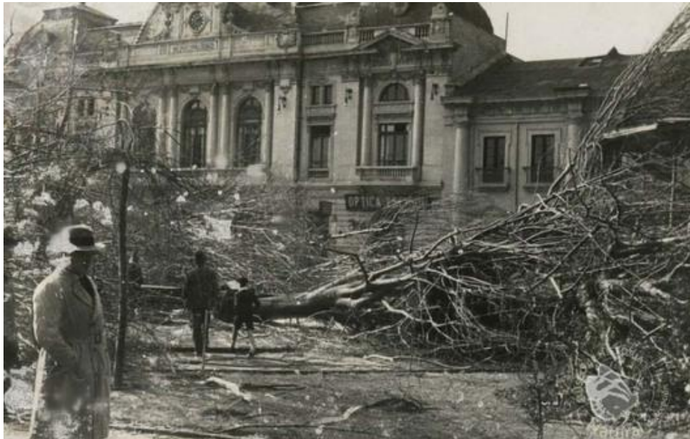
Fig. 65. Efectos del tornado de 1934.
