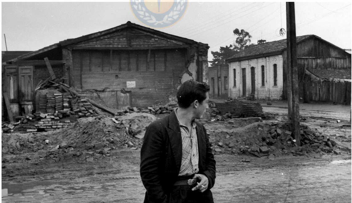
Fig. 35. Sector oriente de calle Los Carrera tras el terremoto.
