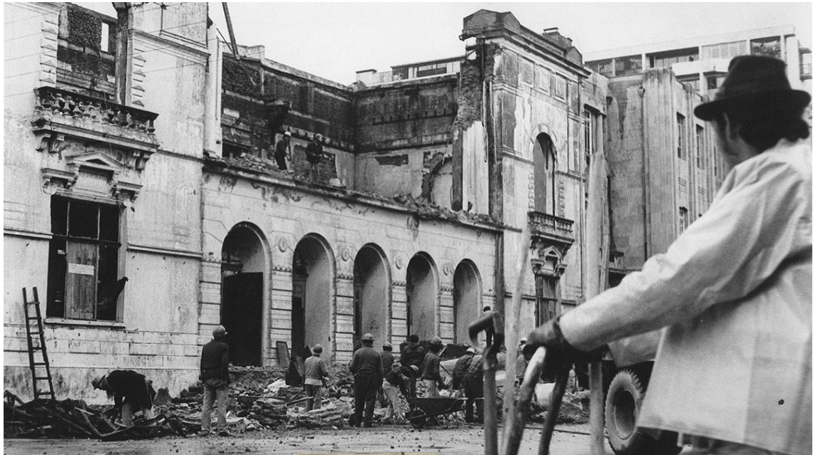
Fig. 91. Demolición del Teatro Concepción, 22 de julio de 1976.
