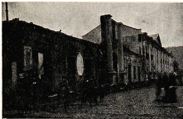
La tesorería municipal incendiada.
