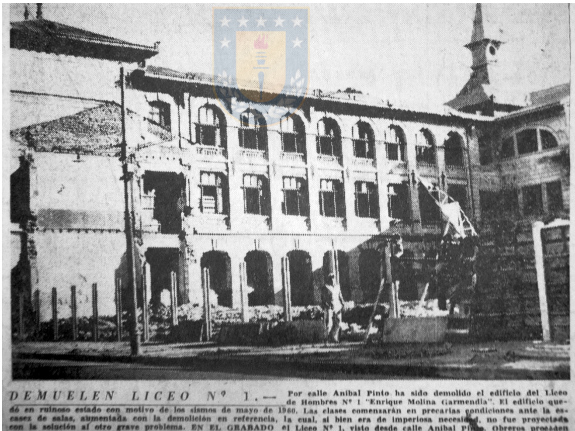
Fig. 36. Demolición Liceo Enrique Molina. El Sur, 1962.
