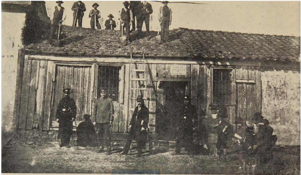
Concepción.—Conventillo de Arturo Elgueta.—Parte del frente.—En demolición.
