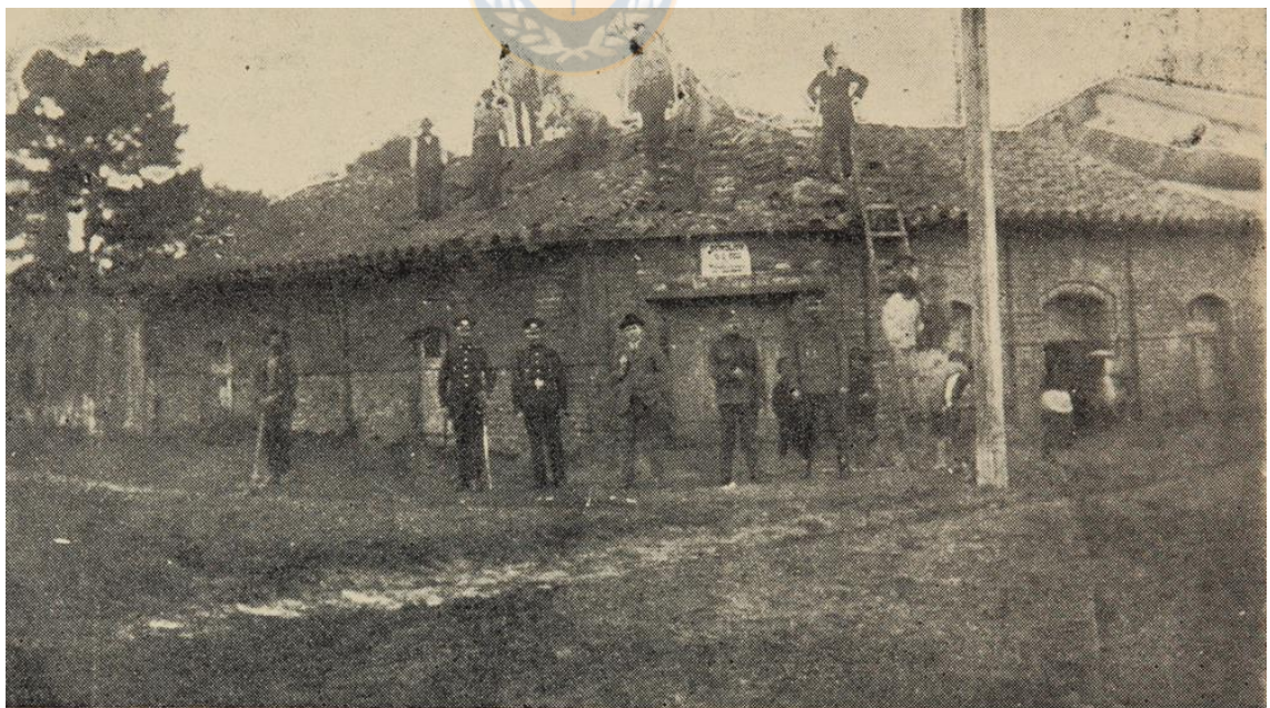
Concepción.—Conventillo de don Cosme Aruta.—Caupolicán-Cruz.—Fachada.—En demolición.
