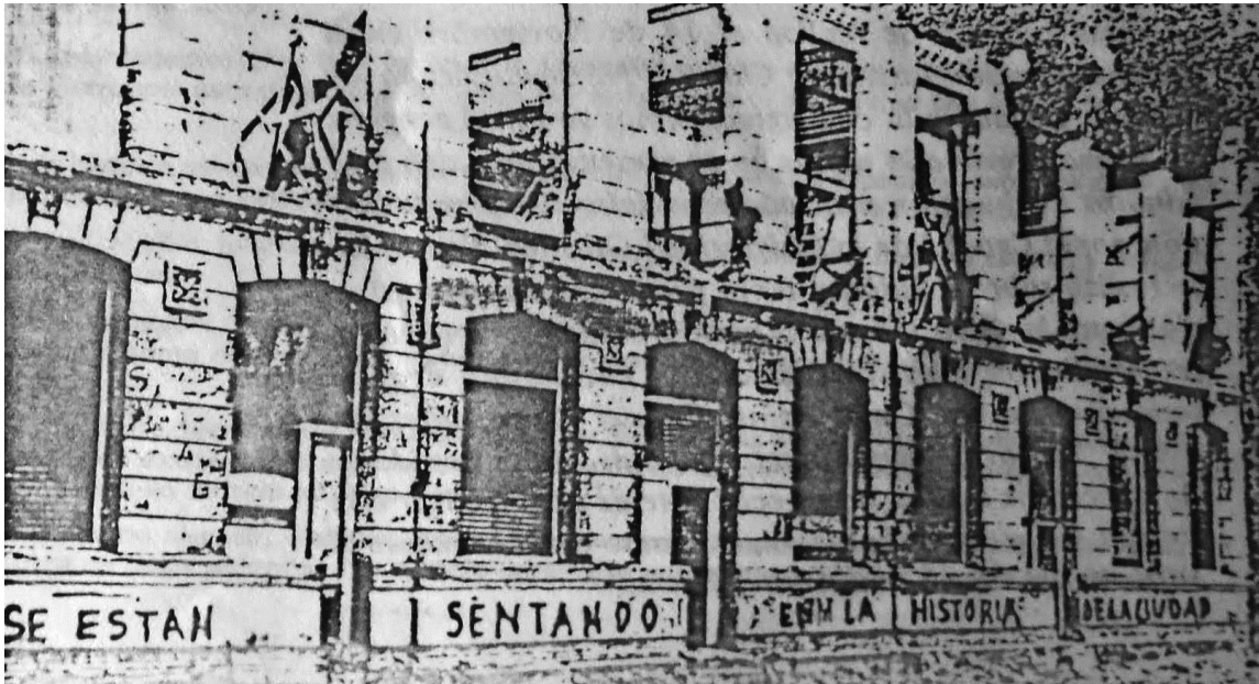
Fig. 94. Demolición del bloque Caupolicán del Liceo Enrique Molina. El Sur, 06.09. 1977.
