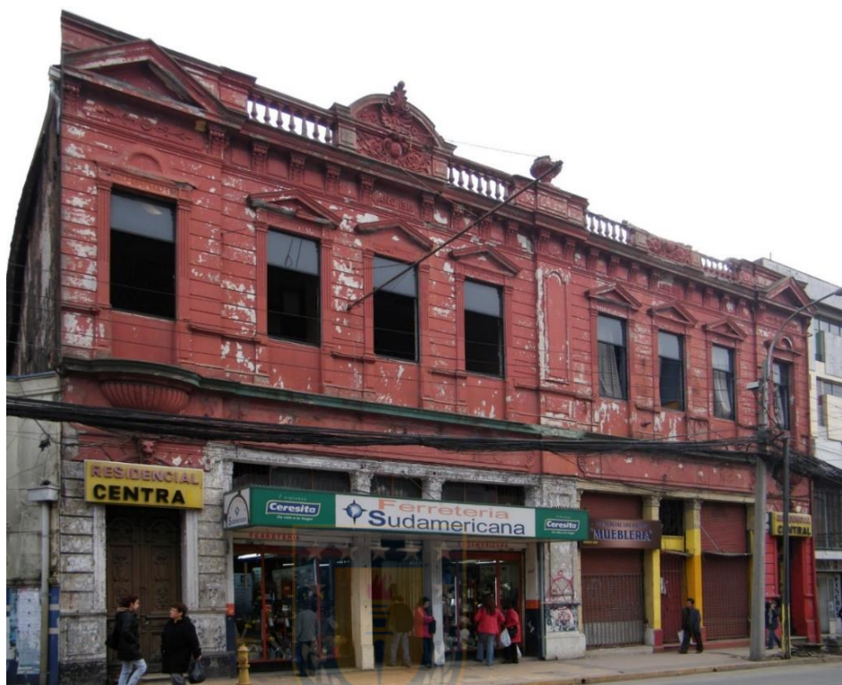
Fig. 7. Casa de altos calle Rengo durante su demolición, 2011.
