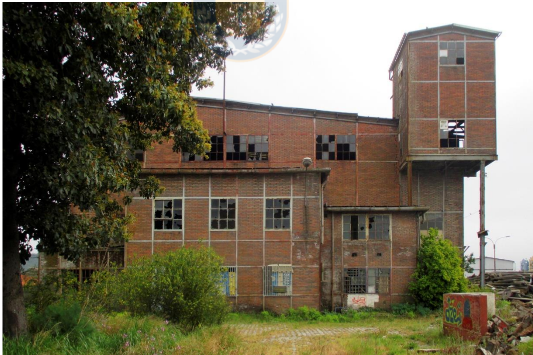
Fig. 10. Termoeléctrica CGEI, vista desde Desiderio Sanhueza
