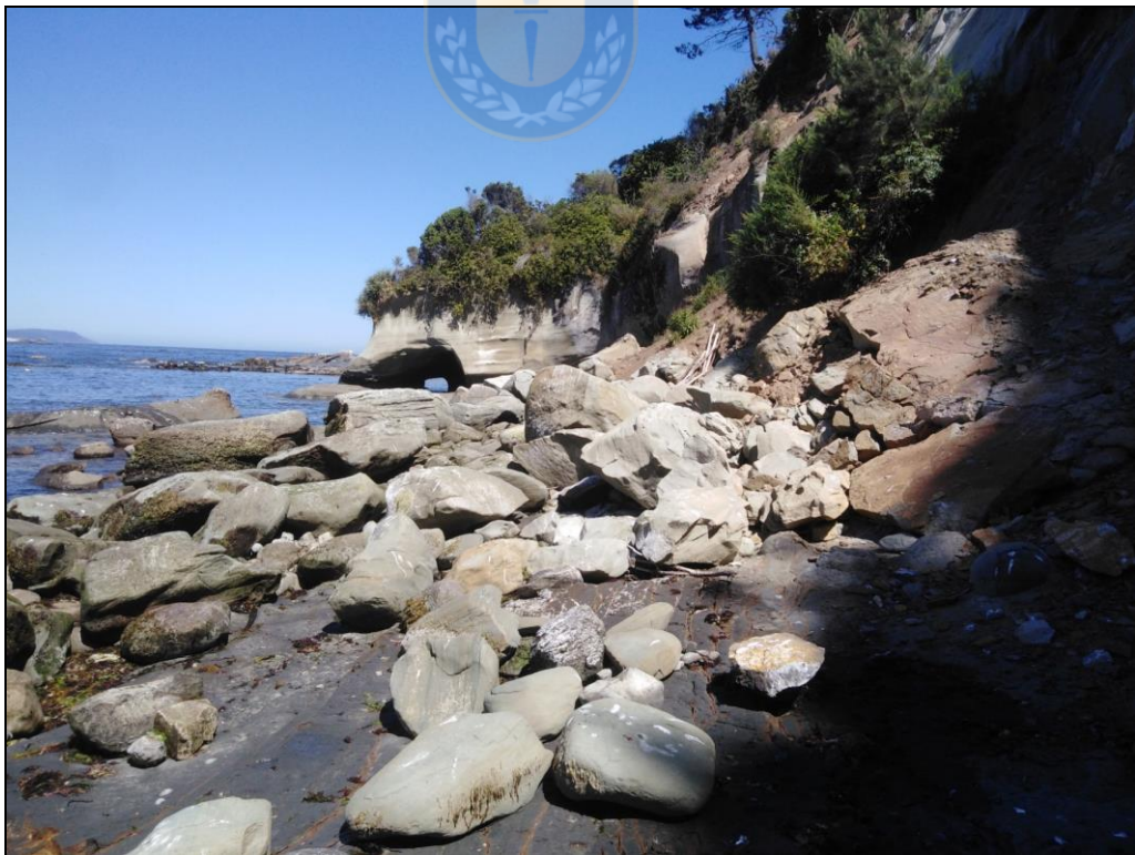
Fotografía 6: Depósitos de remoción en masa en punto 4B.
