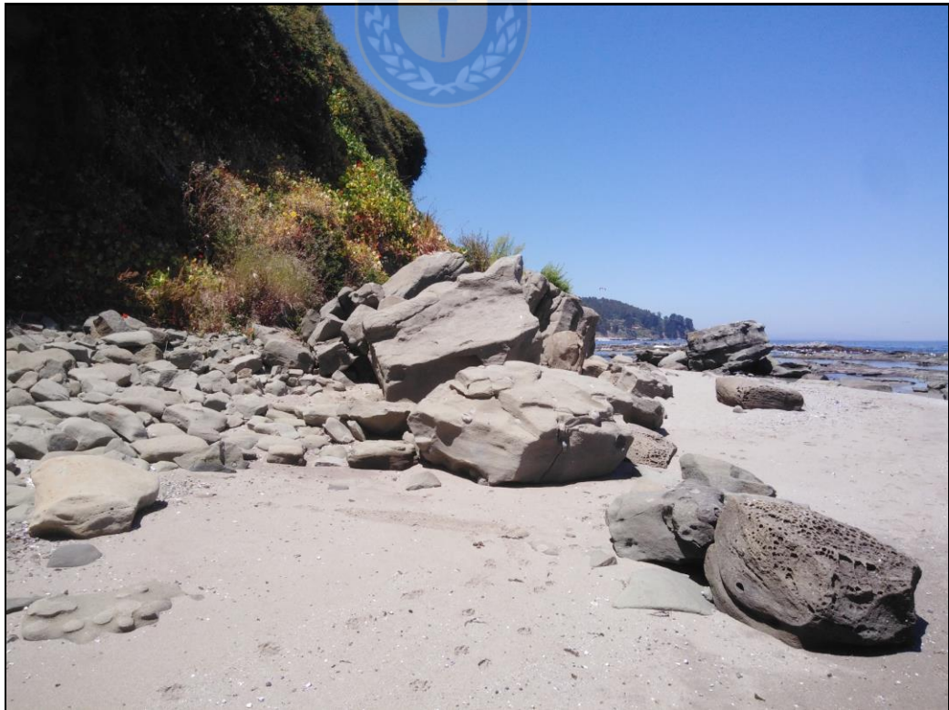
Fotografía 16: Depósitos de remoción en masa en punto 4N.
