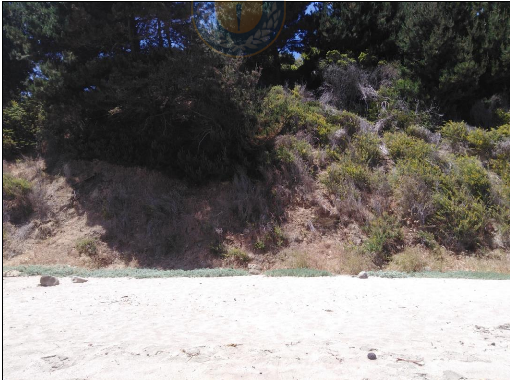
Fotografía 20: Depósitos de remoción en masa en punto 4Q.
