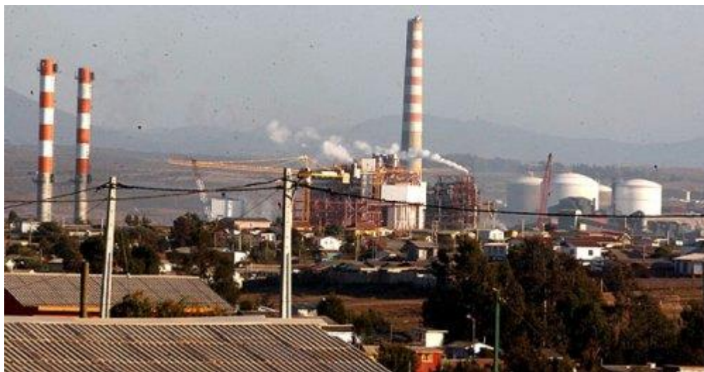
Figura 4. Fase de construcción Central termoeléctrica Campiche.
