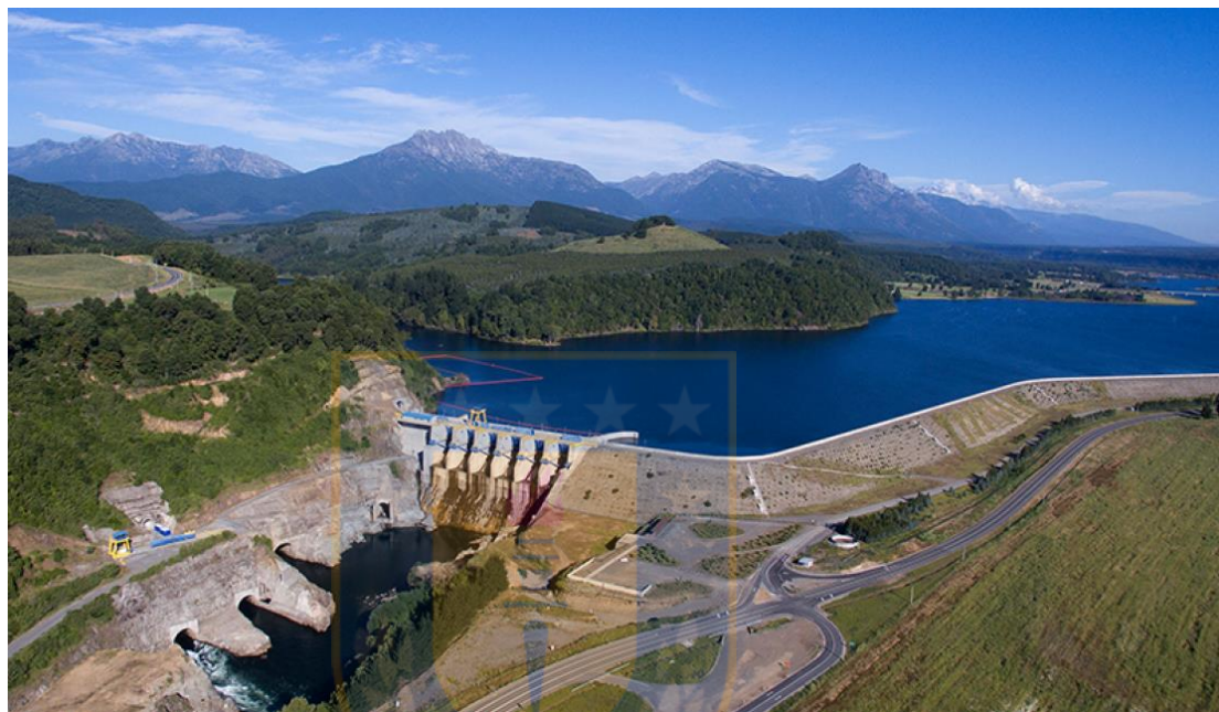
Figura 3. Central hidroeléctrica Angostura.
