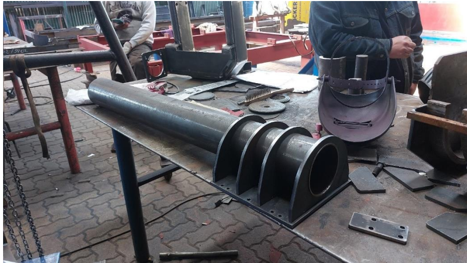
Figura 6.6: Construcción conjunto cañería y conexión con módulo lineal.
