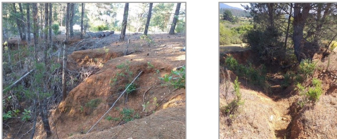
Fotografía 5.1: Cárcavas identificadas en Coronel de Maule. a) Cárcava C5-CM en plantación forestal; b) cárcava C8-CM en uso de suelo pradera-matorral.
