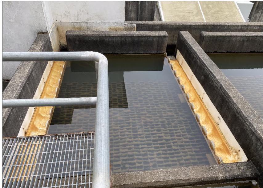
**Figura 27. Sedimentador laminar de la planta de Hualqui.**
