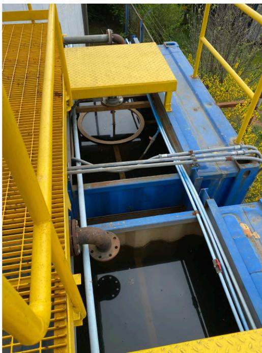
**Figura 14. Cámara de mezcla rápida de floccodecantadores compactos.**
