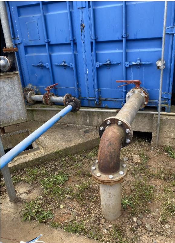
**Figura 33. Cañerías de extracción de agua clarificada (izquierda) y de extracción de lodos (derecha) de floccodecantador compacto.**
