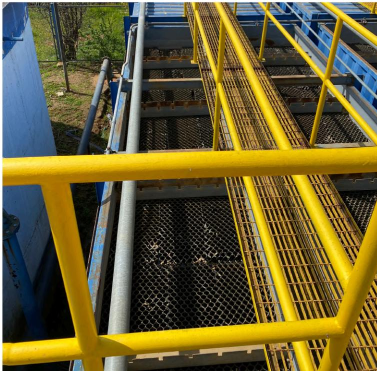
**Figura 15. Cámara de sedimentación de flocculadores compactos.**
