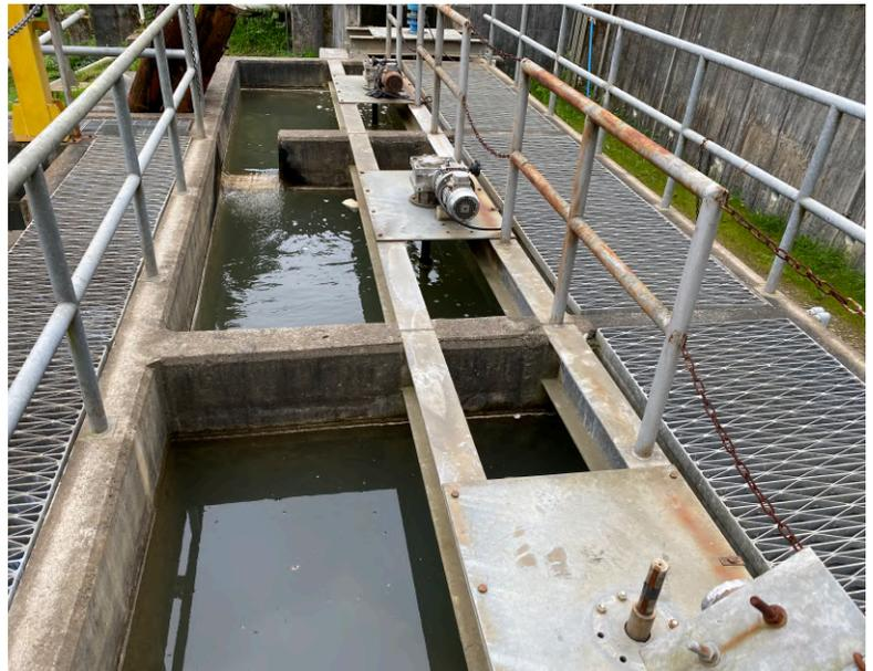
**Figura 11. Equipos floculadores en Planta Hualqui.**
