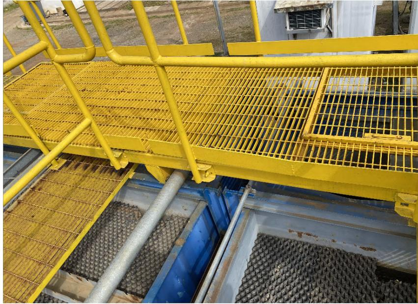
**Figura 32. Vista hacia la cámara de agua clarificada del floccodecantador compacto.**
