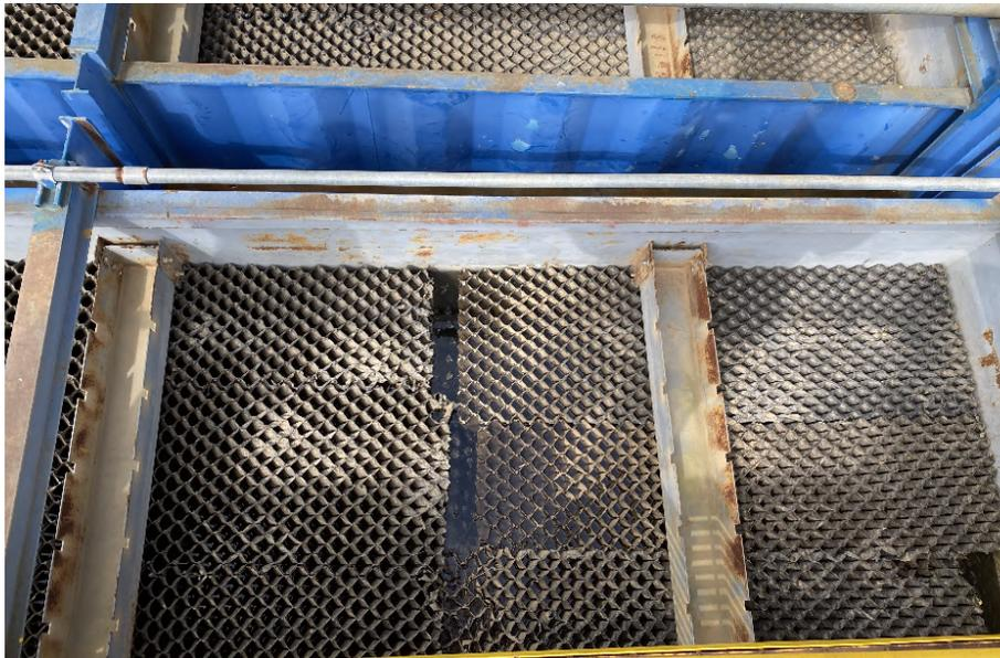
**Figura 31. Sedimentador laminar del floccodecantador compacto.**
