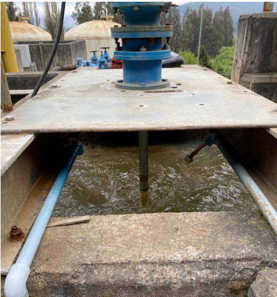
**Figura 10. Equipo de mezcla rápida en Planta Hualqui.**
