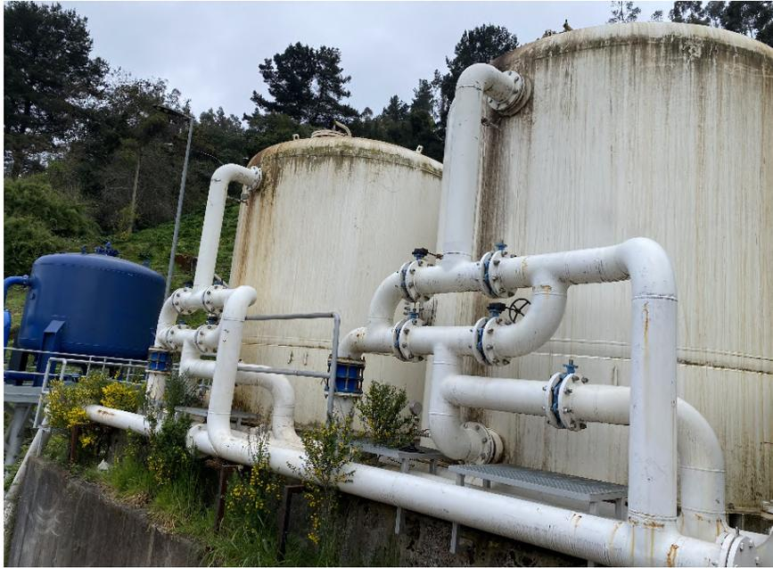
**Figura 28. Filtros de arena de la planta de Hualqui.**
