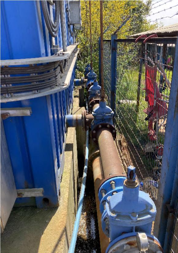
**Figura 29. Vista lateral de la entrada del agua al floccodecantador compacto.**
