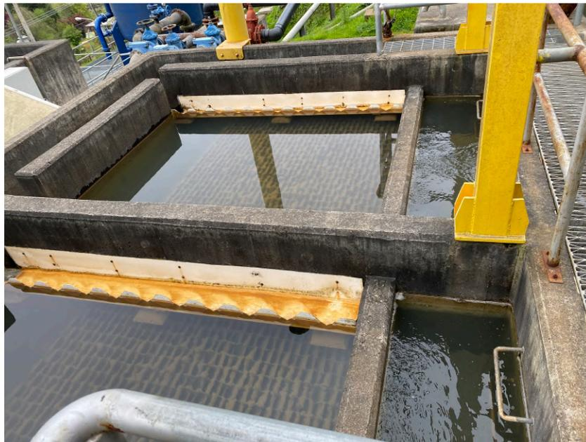
**Figura 12. Sedimentador laminar en Planta de Hualqui.**
