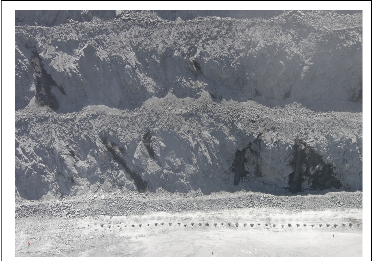
Figura 6.6: Pozos de contorno (precorte) en la zona de Intrusivo Central del banco 120. Las manchas oscuras corresponden a agua fluyendo por las paredes.
