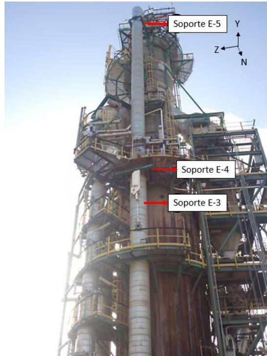
**Figura 14: Soportes en la línea vertical.**
