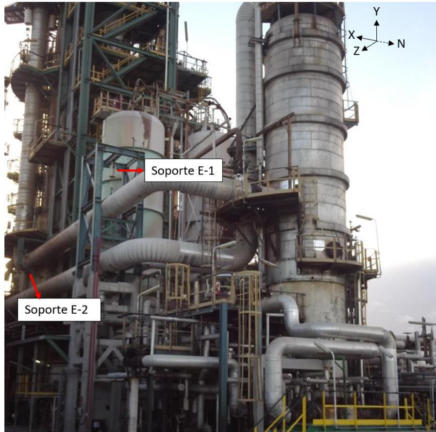
**Figura 11: Soportes en la línea horizontal.**
