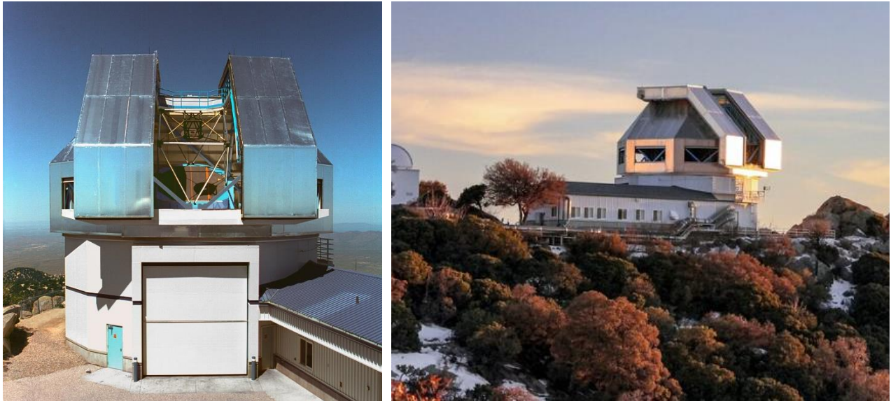
Figura 3.21 y 3.22: Apertura y vista general domo telescopio WIYN. [31]
