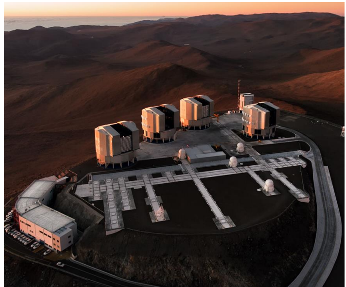
Figura 3.2: Vista aérea domos en observatorio Paranal [15]
