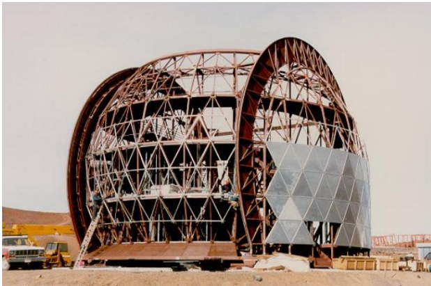
Figura 3.29: Etapa de construcción domo para telescopio Leighton. [36]
