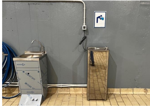
Figura 5.6: Instalación bebedero y lavamanos en planta.
