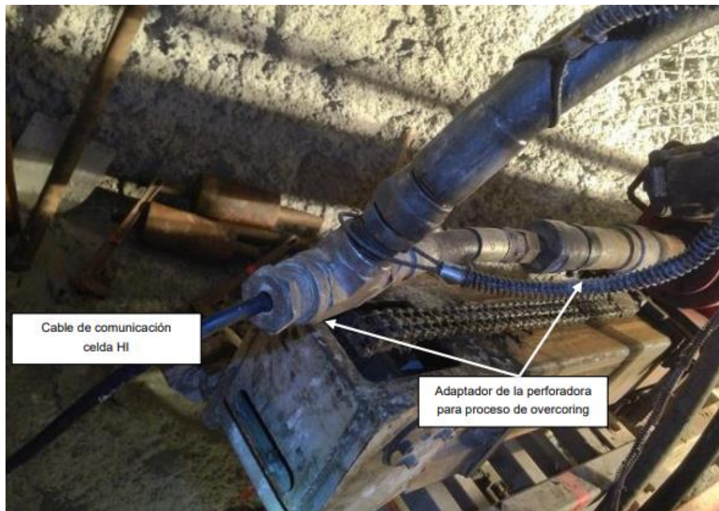
Figura 8.1: Adaptador instalado en perforadora para proceso de overcoring [14].
