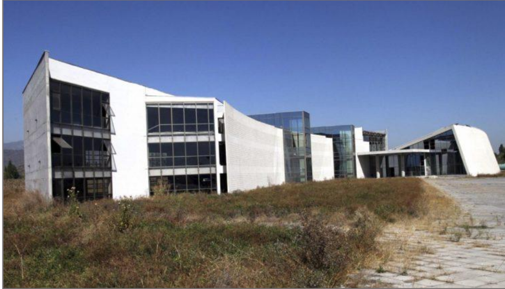
Figura 1.1: Edificio abandonado de la Ex Universidad de Valparaíso, sede Rengo.
