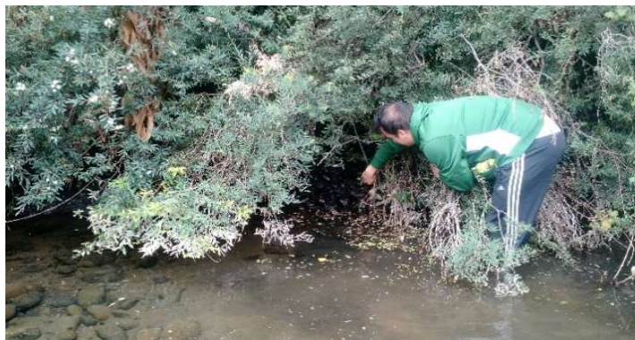
Figura 26. Ingreso de aguas subterránea. Fuente: Elaboración propia
