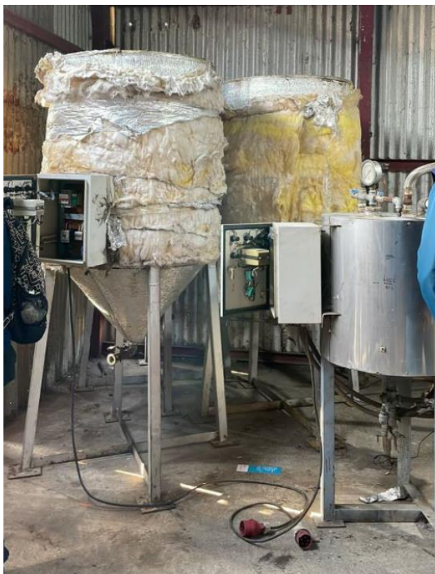
Figura 3.2: Estado actual de la planta. Fuente propia.
