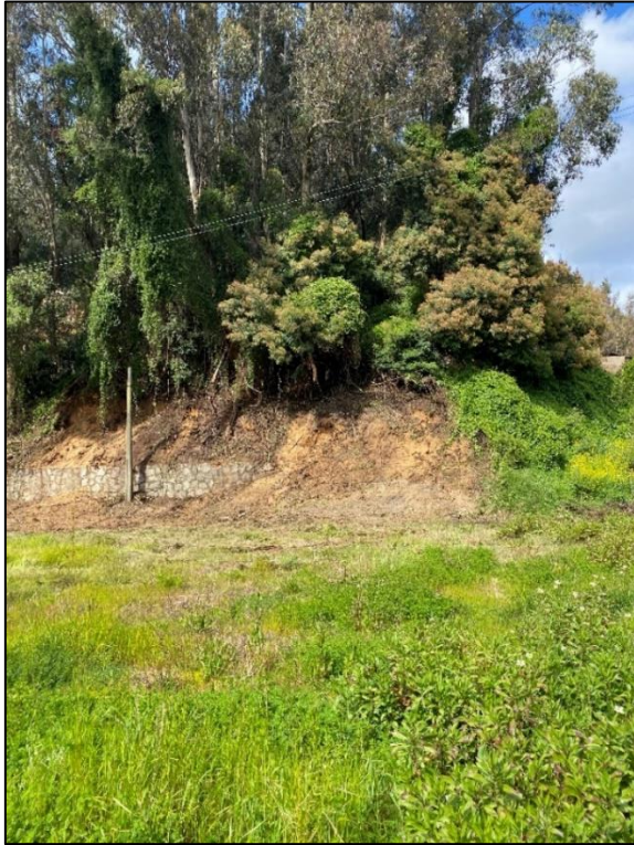
Figura 5.18: Remoción en masa reconocida en sector Lagos de Chile.
