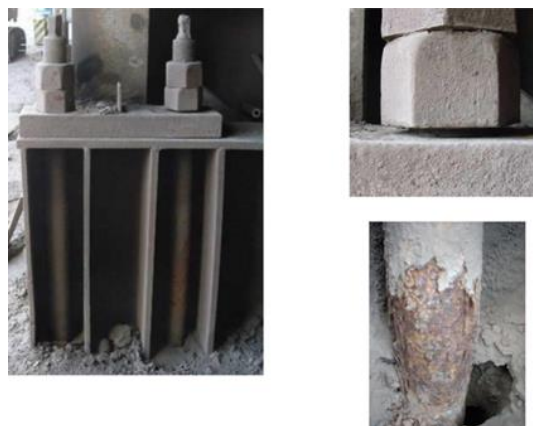
Figura 1.2. Fluencia pernos de anclaje. (Soules et al., 2016)
