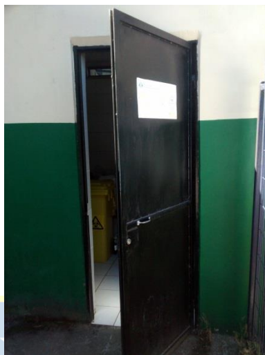
Figura 8: Ingreso de la bodega de sustancias peligrosas.
