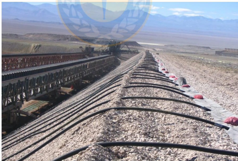
Figura 18. Vista desde lo alto de la pila del proceso de instalación del conjunto de aireación en medio de la pila de lixiviación. Fuente: Elaboración propia.
