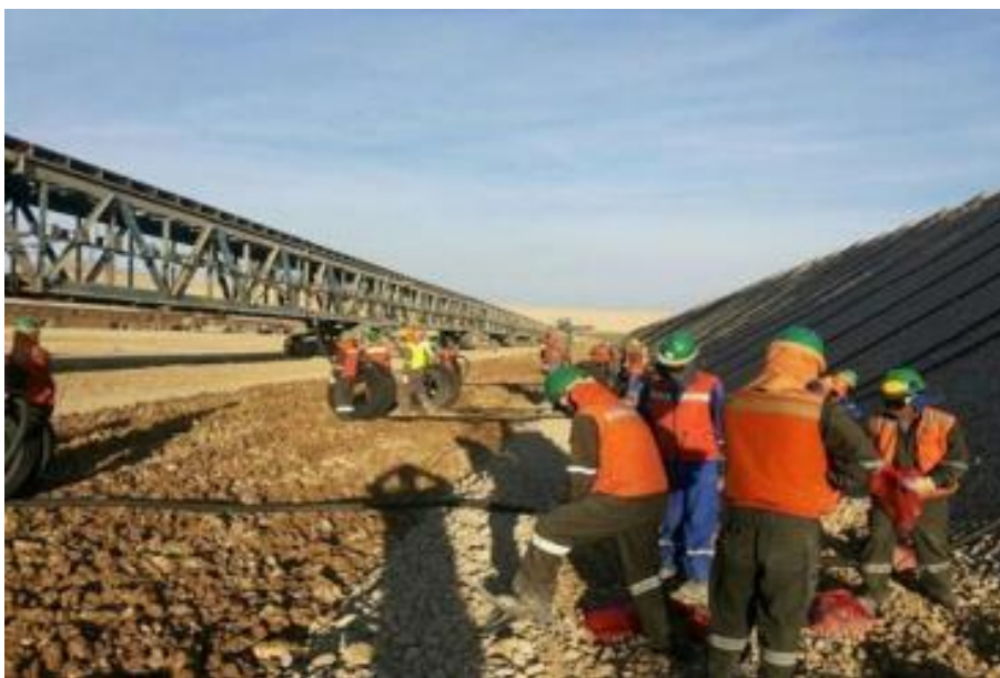
Figura 19. Continuación del proceso de instalación del conjunto de aireación. Fuente: Elaboración propia.
