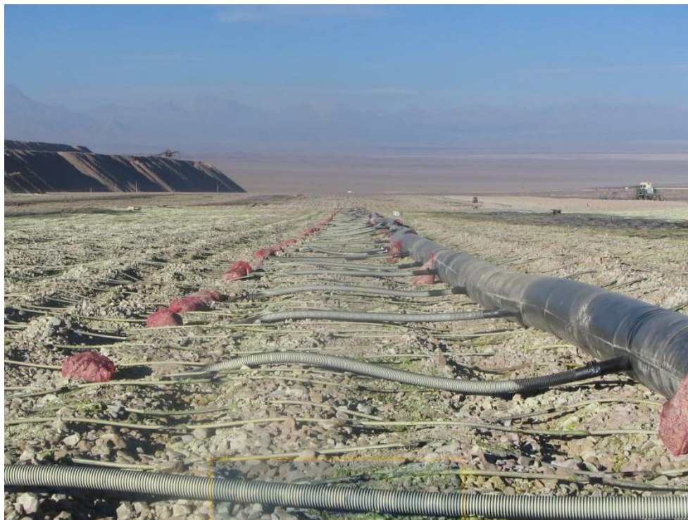
Figura 36. Vista final de Mangas y drenaflex instalada sobre Pila, con la respectiva malla de riego por goteo.
