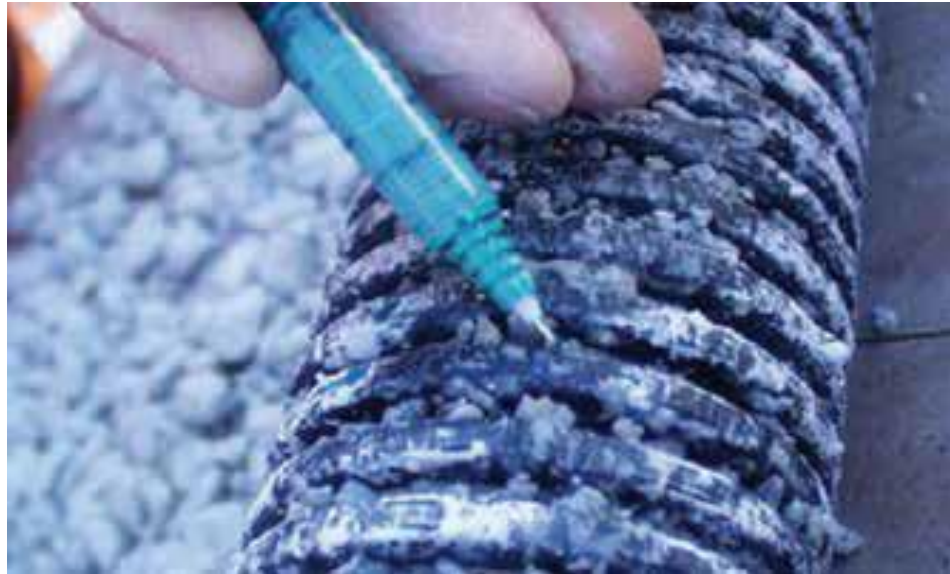
Figura 37. Taponamientos líneas drenaflex.
