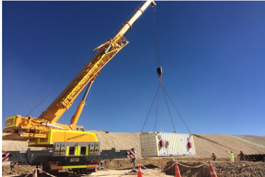
Figura 16. Proceso de instalación de kit de aireación a un costado de la pila. Fuente: Elaboración propia.
