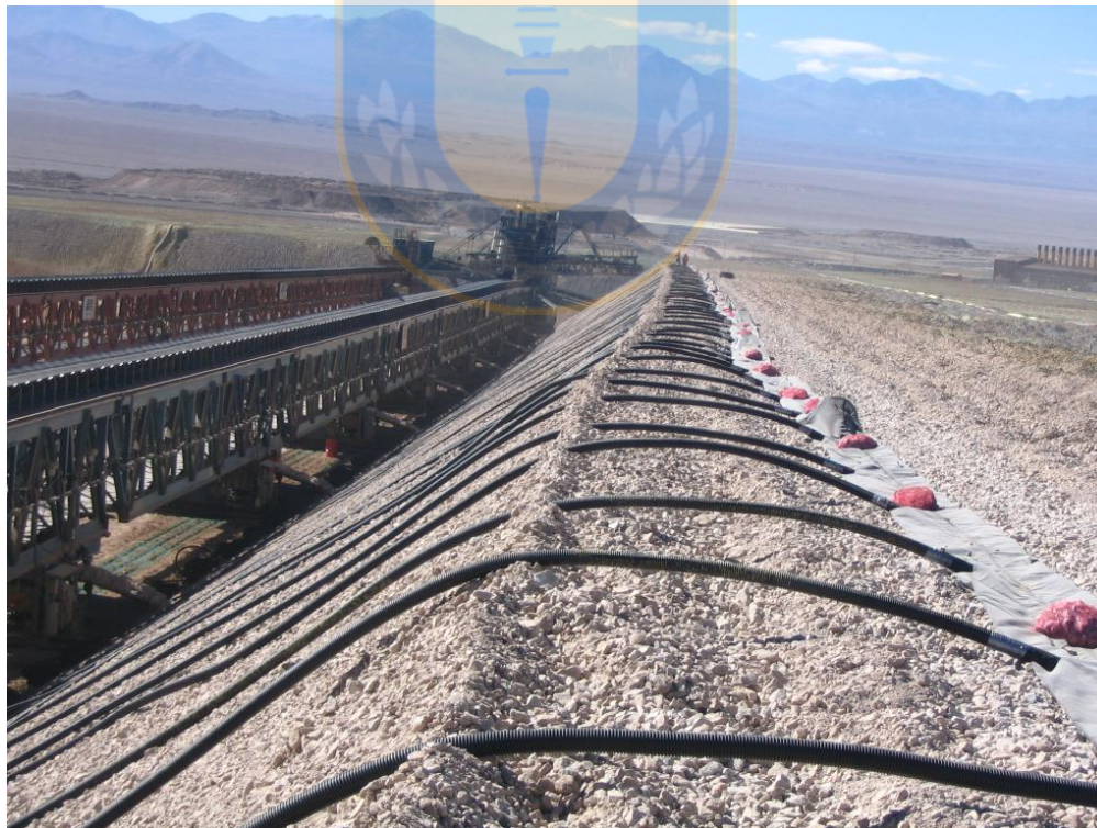
Figura 31. Manga de aireación instalada a los pies del talud de la pila.
