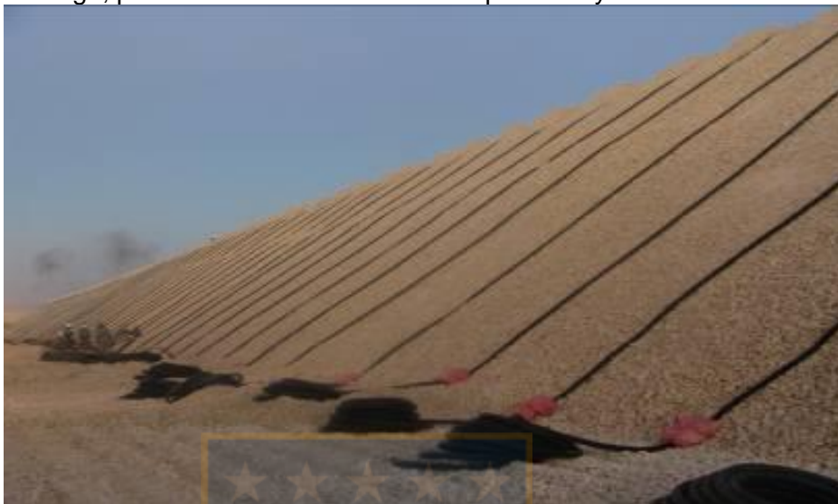
Figura 33. 1° Tramo drenaflex instalado
