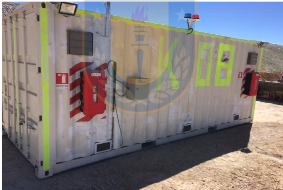
Figura 15. Kit n° 08 de aireación instalado. Fuente: Elaboración propia.
