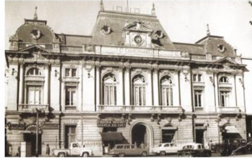
Antigua municipalidad de Concepción, construida en 1920
