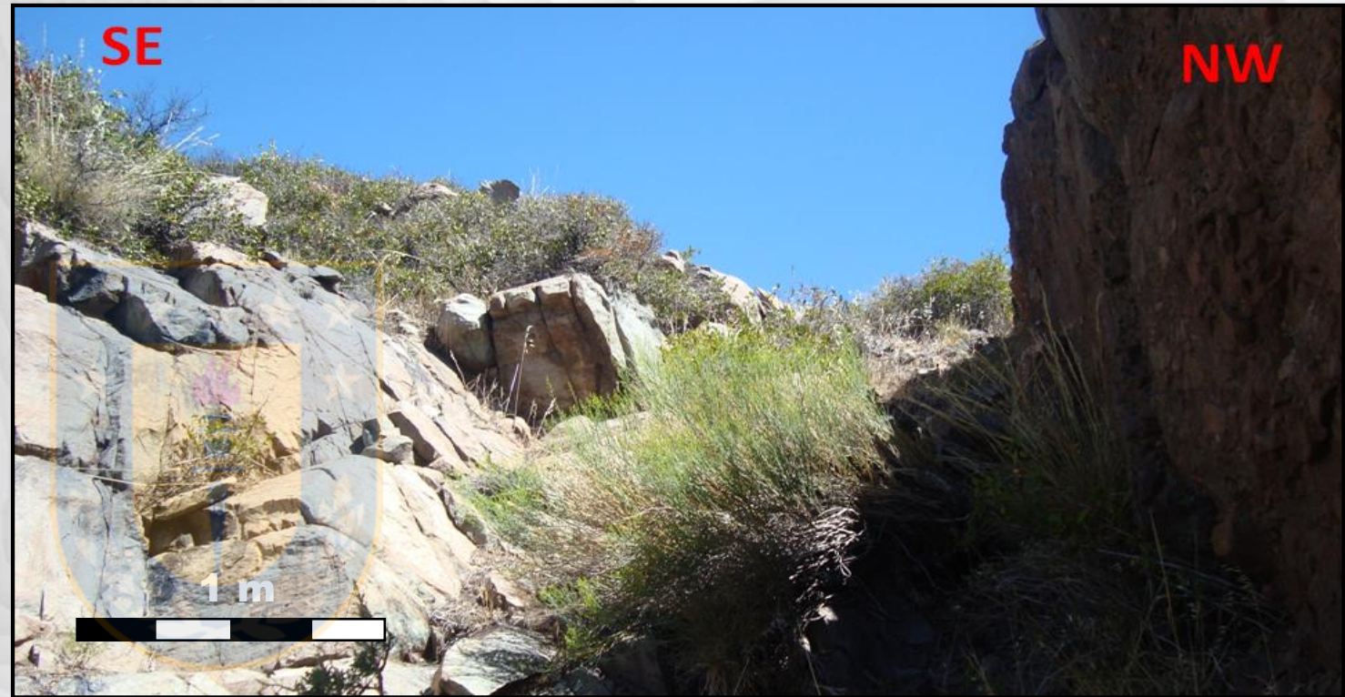
Dique de composición andesítica parcialmente erosionado perteneciente a la Unidad intrusiva KTsl afectando a aglomerados aguas abajo de la ladera izquierda del sitio de presa.
