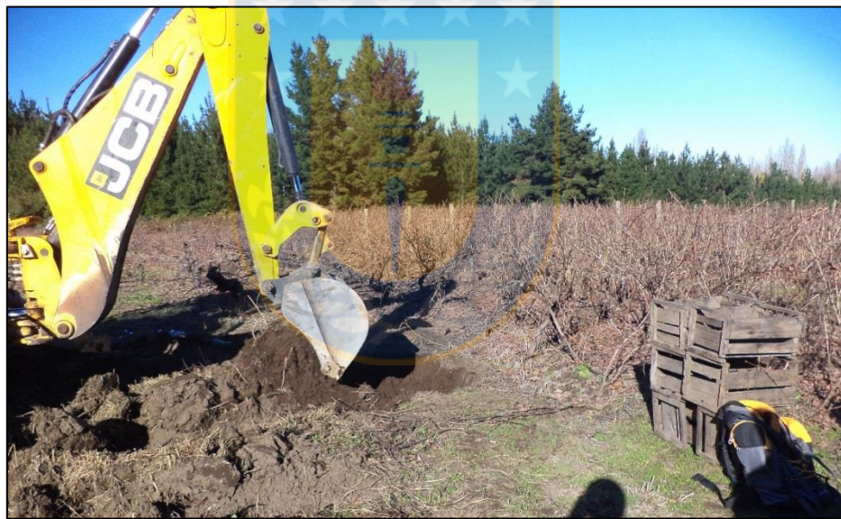
Fotografía 2.4: Excavación de calicata en sector Turquía Norte.
