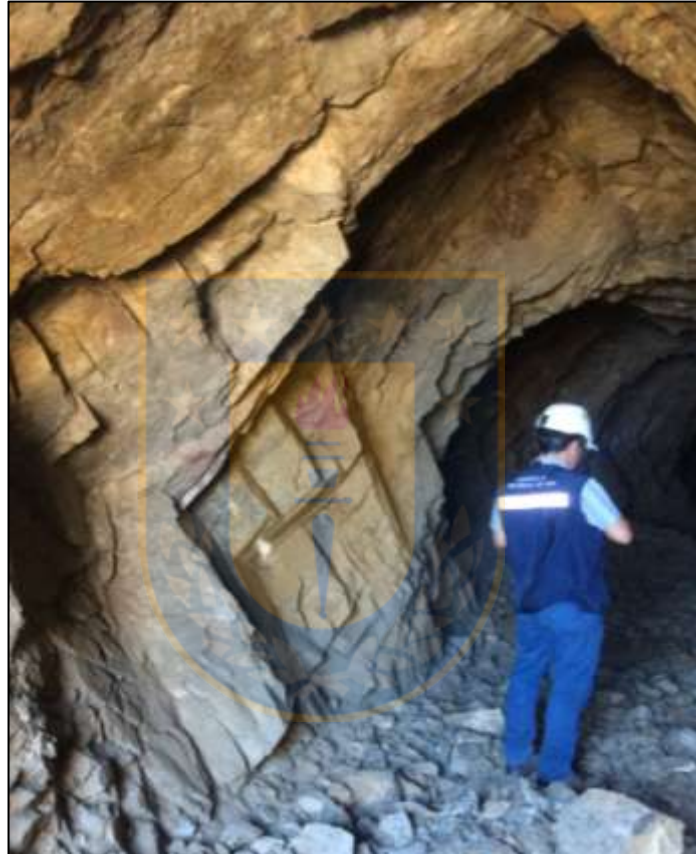
Figura 4.2 Familias de diaclasas en el tramo 1 del Socavón Los Pequeños.
