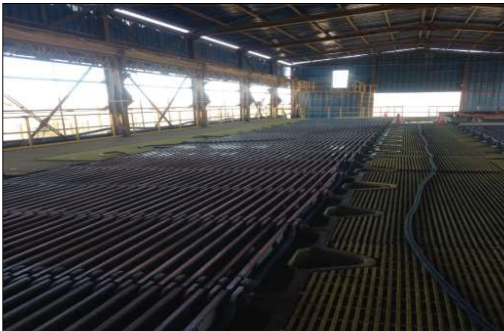
Figura 10. Nave de Electro Obtención, Planta de Óxidos, Las Cenizas, Taltal.
