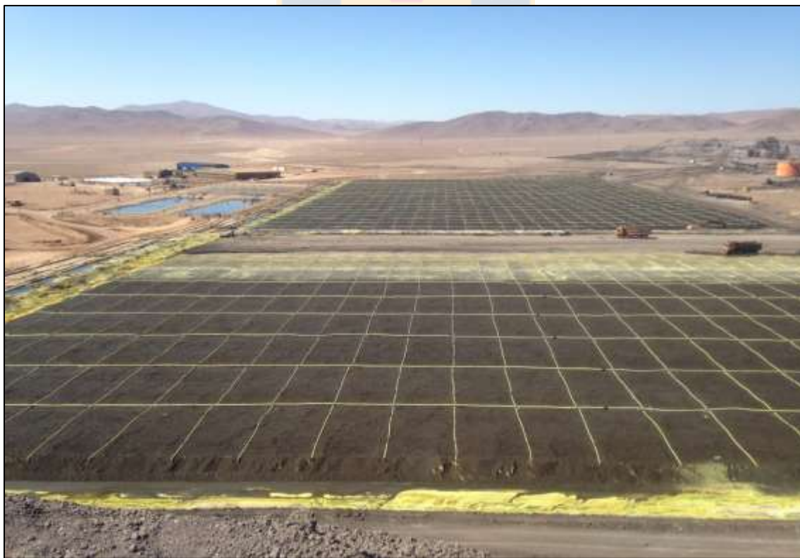
Figura 8. Pilas de lixiviación Planta de Óxidos, Las Cenizas, Taltal.
