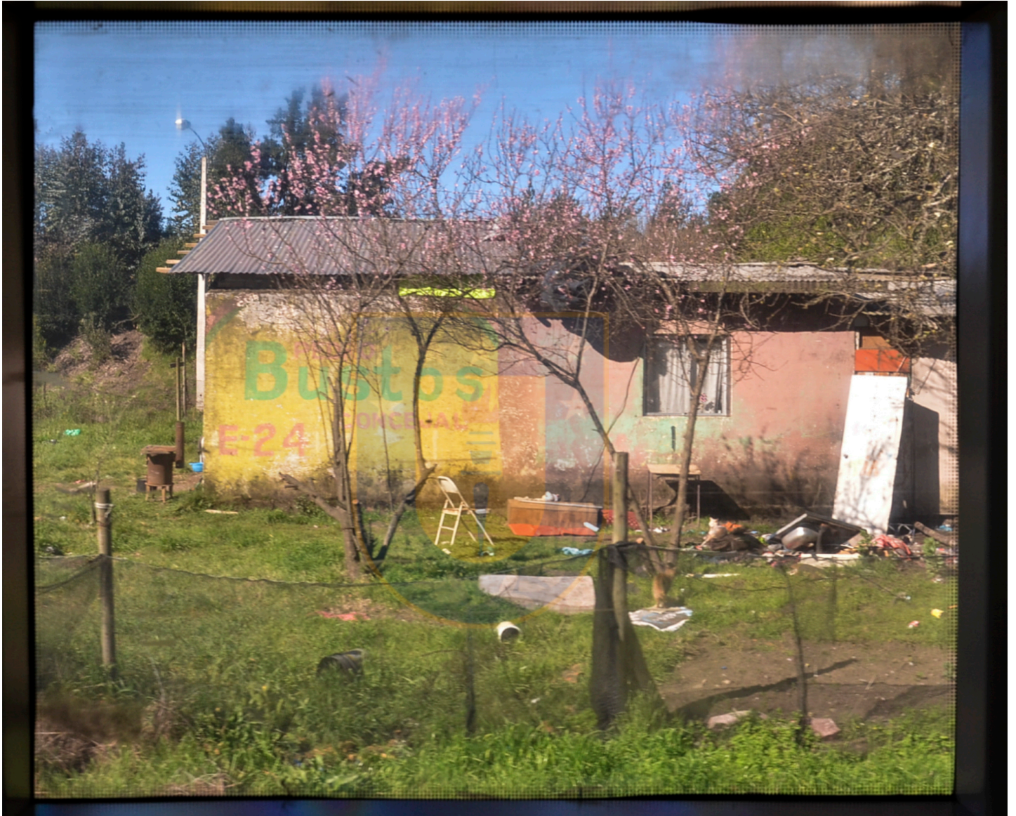
2. Fotografía tomada el día miércoles 12 de Septiembre de 2017 a las 16:44 horas entre estaciones San Miguel y Unihue hacia el lado del cerro.
