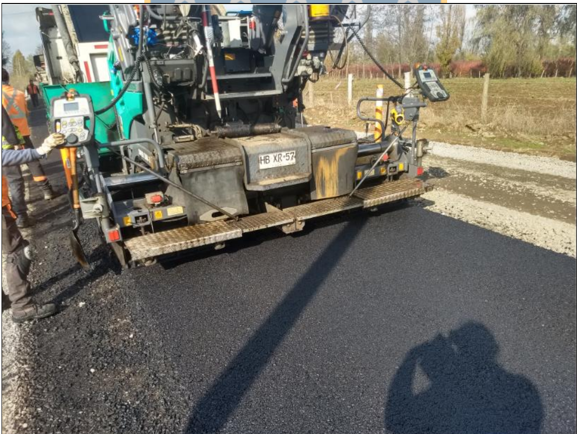
Ilustración 2: Pavimentadora o Finisher colocando la capa asfáltica sobre la base
