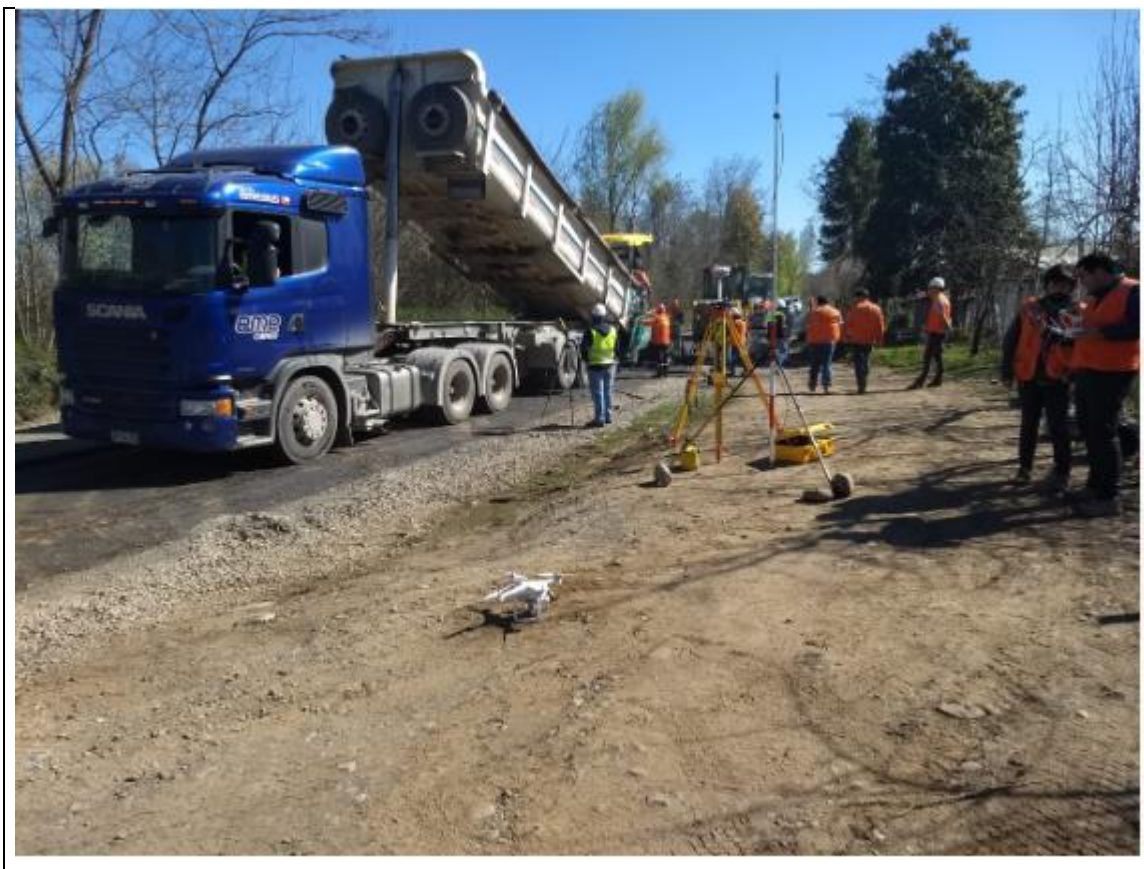
Ilustración 9: Dron Phantom 3 Pro Utilizado en Obra de Pavimentación
