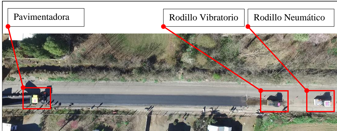
Ilustración 10. Pavimentadora, Rodillo Vibratorio y Rodillo Neumático presentes en obra de pavimentación
