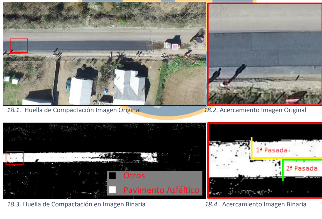
Ilustración 17. Compactación Dispareja del Rodillo Vibratorio Sobre el Pavimento Asfáltico, Video DJI_0620.MOV
