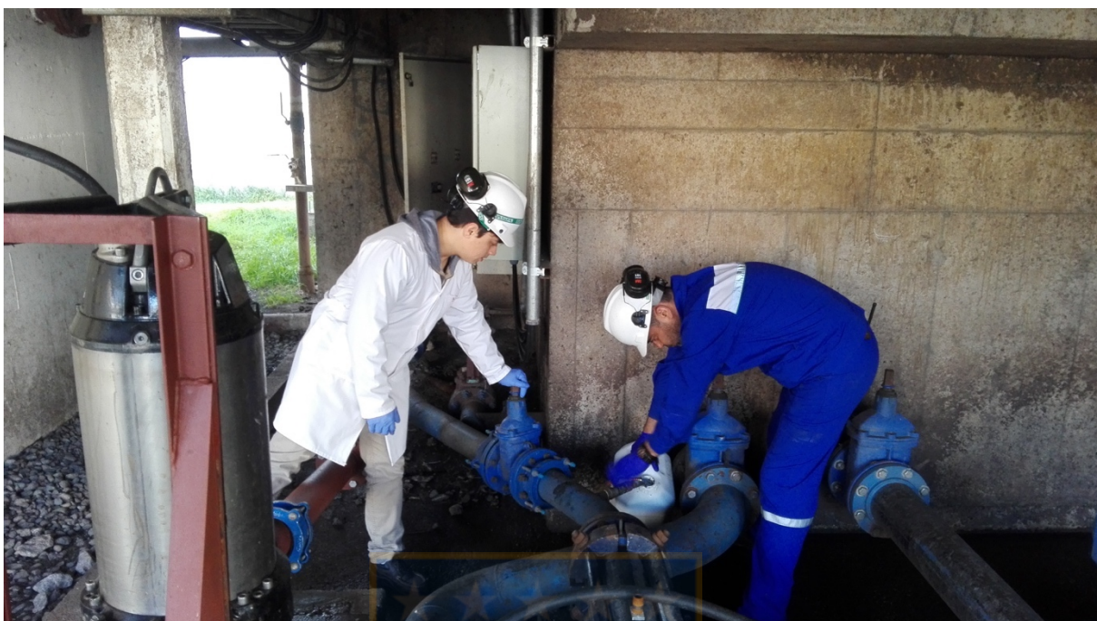
Figura 6. Extracción de lodo mixto desde la cámara de mezcla de la PTAS Hualpén.
