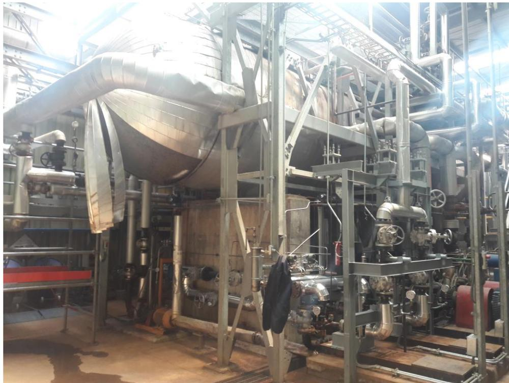
**Figura B.1 Estanque de condensado primario.**
