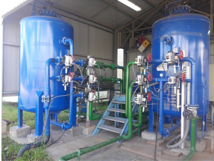
Figura B.11 Filtros de planta de agua potable.
