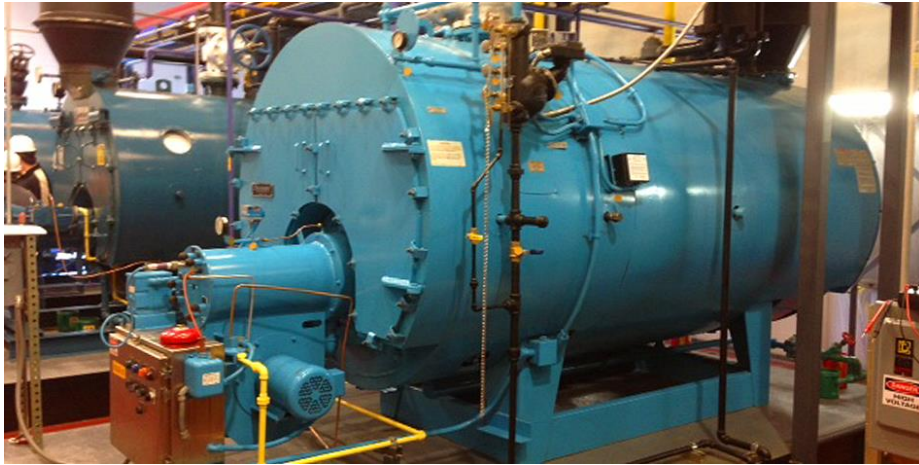
Fig. B.3 Caldera de calefacción central.
