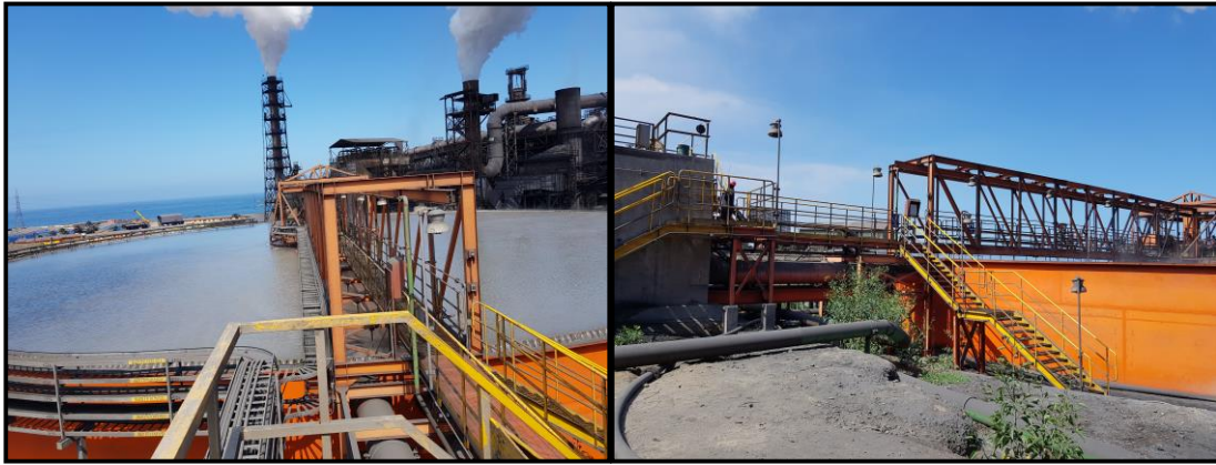
Figura 11: Espesador de relaves 3. Planta de Pellets
