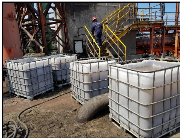
Figura 13: Isocontenedores con muestra de relaves. Planta de pellets.
