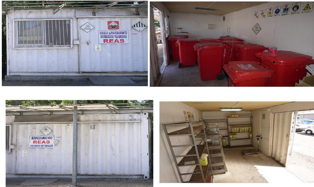
Figura 24: Bodegas de almacenamiento transitorio de residuos peligrosos y especiales respectivamente.
