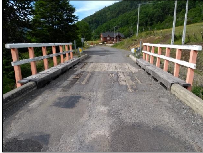
Figura 4.13 Vista frontal del Puente Corralco.
