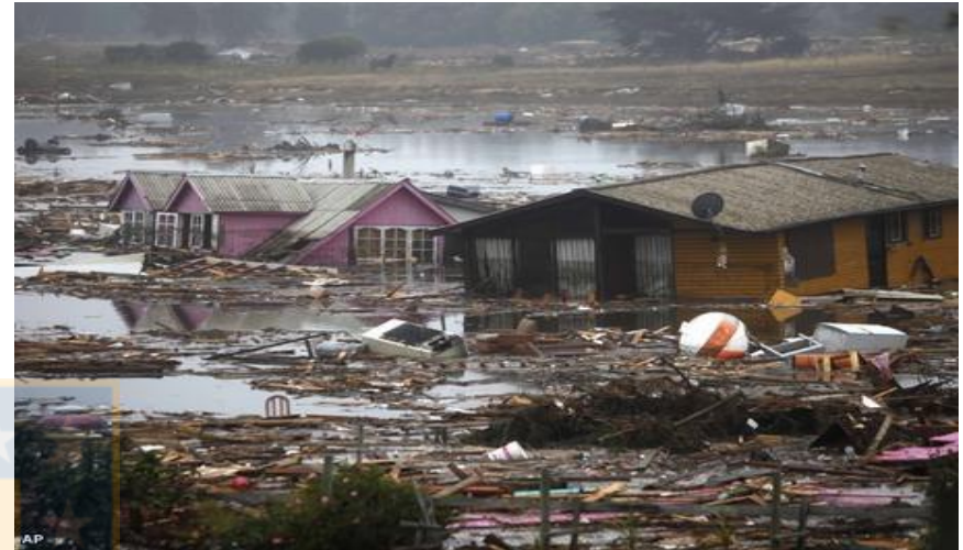
Figura N°3 costa chilena después del tsunami
