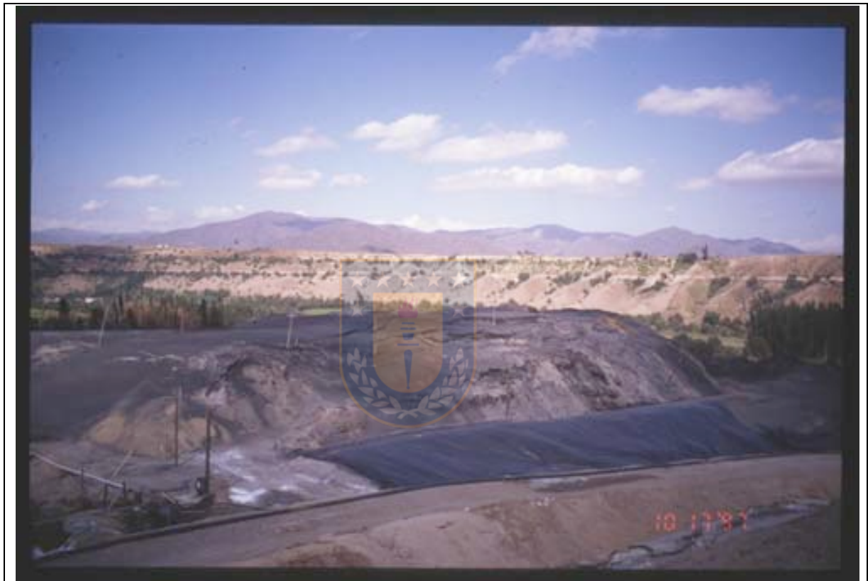
Figura 5.4. Tranque de Relaves N°1. Licuefacción y deslizamientos por efectos del sismo del 14 octubre 1997 (Espinace & Villavicencio, 2004)
