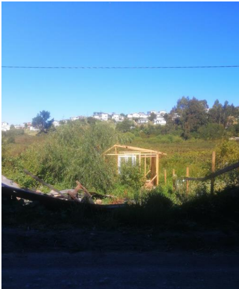
Imagen 24: vivienda en construcción en el humedal
