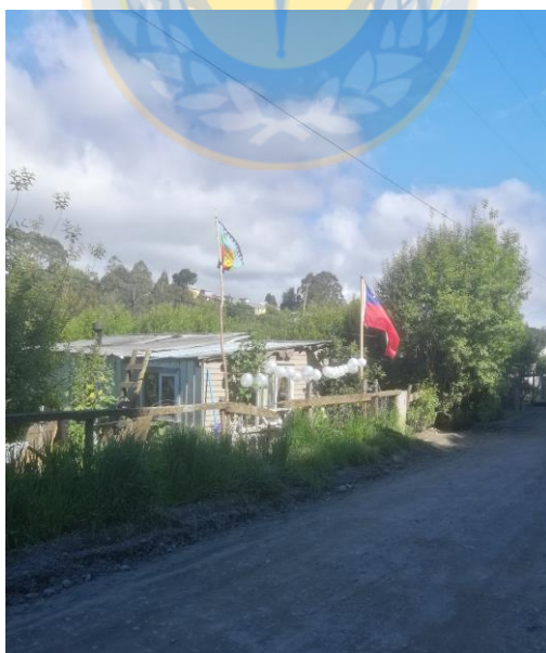
Viviendas del campamento Camino Agua potable, Ancud.
