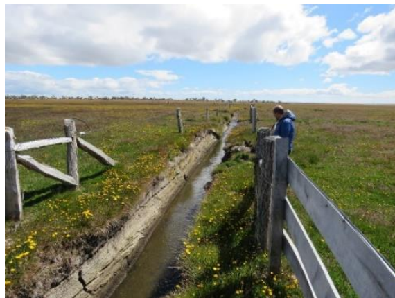
Figura 1. Drenes ubicados en la Vega Magallánica de la estación experimental Kampenaike. Fuente: Elaboración propia.
